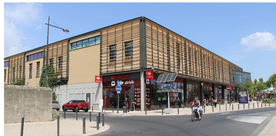
Immeuble commercial – Place Morgan à Salon-de-Provence
